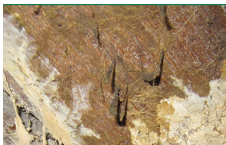
Viftesvamp - karrygult overflademycelium. (Foto: Bøgh & Helstrup)
