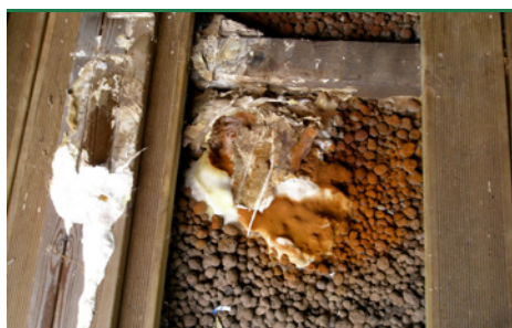
svn 4 Ægte Husk - frugtlegeme, kakaolignende sporepulver og mycelium på lecanødder under gulv i udestue. (Foto: Protox/kundefoto)
