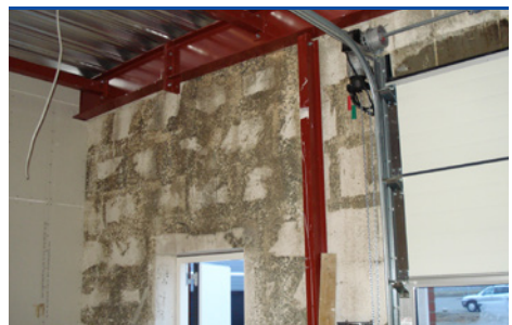
Skimmelvækst på nyopført væg i industriel som følge af byggefugt. (Foto: Prottox)
