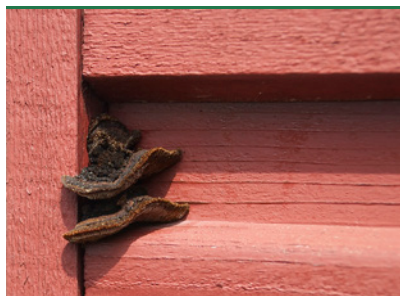
Korkhat - frugtlegemer på beklædningstræ, fritidshus. (Foto: Protox)
