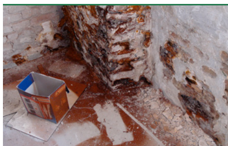
svn 5 Ægte Husk - rødbrunt sporepulver på gulv. (Foto: Protox)
