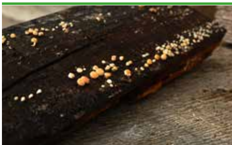
svn 16 Rotplätt - fruktkroppar på takfotsbräda (foto - Protox)
