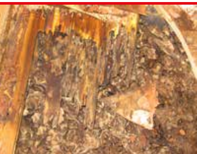
i 26 Blanksvarv trämyra- golvplank nedbruten av Blanksvarv trämyra (foto - Protox/kundefoto)
