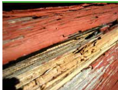
Korkmussling - nedbrytning med typisk bladning av årsringarna. Timmerstuga (foto - Protox)
