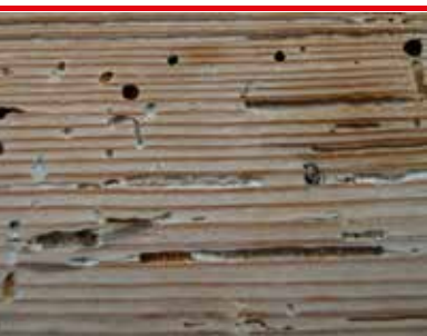
i 11 Strimmig trägnagare - golvbräda med blottade larvgångar som följd av avhyvling (foto - Protox)
