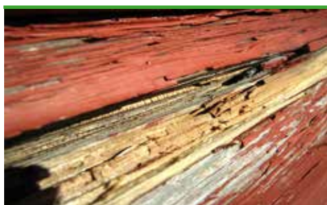
svn 48 Korkmussling - bladad nedbrytning i timmerhus (foto - Protox)
