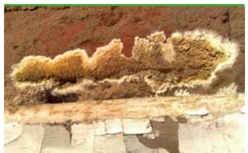
svn 6 Pulverskinn - fruktkropp på tegelsten (foto - Goritas)
