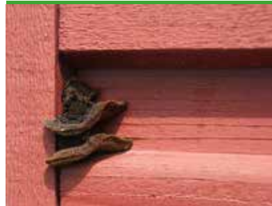
Korkmussling - fruktkroppar på träfasad, frittidshus (foto - Protox)
