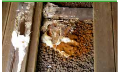
svn 4 Äkta Huskvamp - fruktkropp, kakao- liknande sporpulver och mycel på lecakulor under golv i uterum (foto - Protox/kundfoto)
