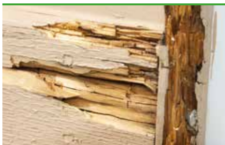
svn 47 Korkmussling - nedbrytning i träfasad i sommarstuga. Angrepp 3-4 år gammalt (foto - Protox)
