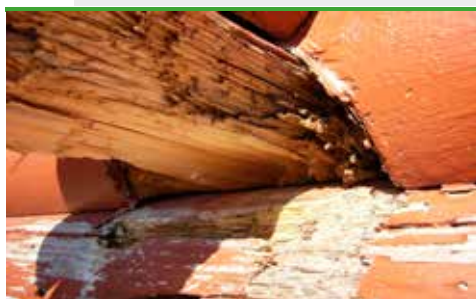
svn 46 Korkmussling - nedbrytning i timmerhus (foto - Protox)
