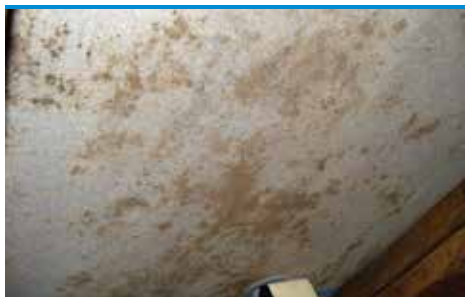
skn 9 Mögelpåväxt på diffusionstätta undertak (filityta) (foto - Protox)
