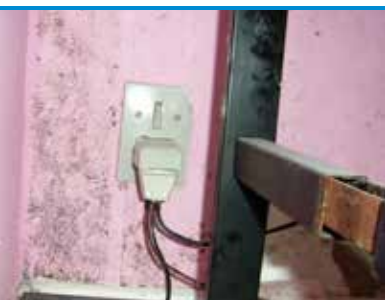
sk 2 Mögelpåväxt på tapet - köldbrygga i nordväst-vänd hörna (foto - Protox)
