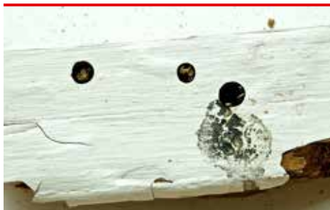
in 14 Röd blombock - flyghål i dörrkarm (foto - Protox/Gorits arkiv)
