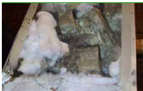
svn 29 Äkta Hussvamp- ungt ytmycel, 2 veckor (foto - Protox)
