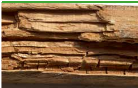
svn 43 Knöliticka (Mögelicka) - nedbrytning (foto - Protox)
