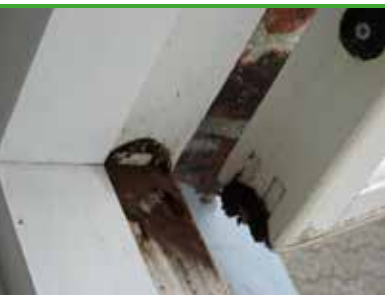
sv 38 Slemsvamp - brusten fruktkropp med sporpulver (foto - Protox)
